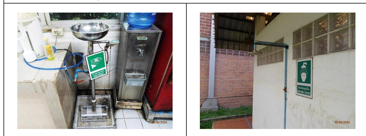
รูปที่ 44 ฝักบัวและอ่างล้างตาฉุกเฉิน
