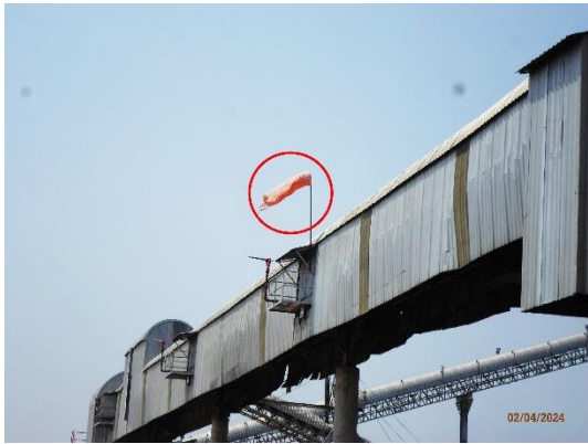
รูปที่ 7 ทุ่งลมบอกทิศทางลม (Wind Sock)
